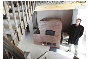
Kun talon keskellä sijaitsevat niin sauna kuin puuhellakin, talo lämpiää kuin itsestään, tutkii Harri Metsälä. Uneista lähtevän savun lämpö otetaan talteen ja sillä lämpiäviä myös käyttöviesiä.
